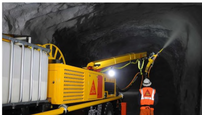
2.2-сурет - Шашыратқыш бетонмен жұмыс істеу көрінісі
